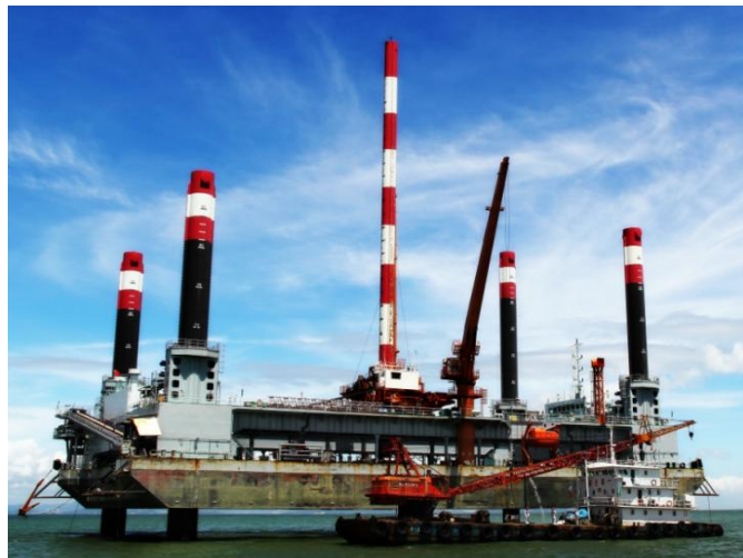
隧道基础碎石整平船
