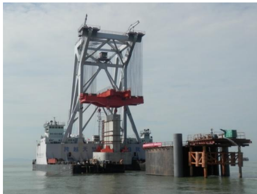
“小天鹅号”墩台吊装船
