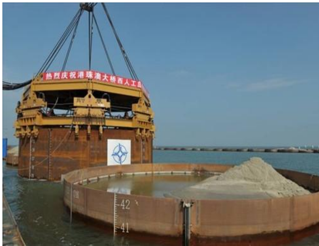
岛隧工程钢圆筒围堰插打
