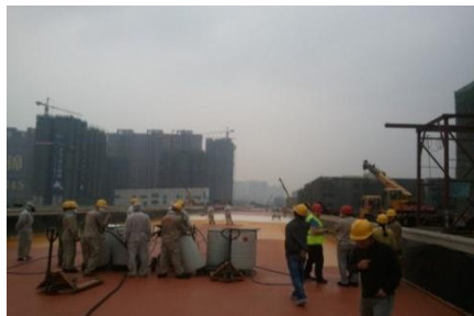
考察成都二环喷砂除锈、防水施工
